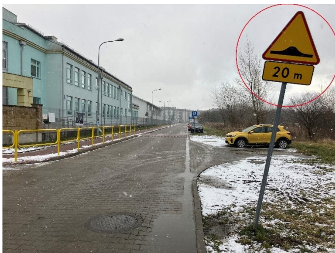
Zdjęcie 38: Przekręcona tarcza znaku A-11a „próg zwalniający”. Źródło: własne.
