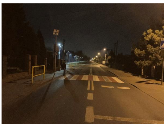
Zdjęcie 4: Oświetlenie przejścia przy ul. J. Kusocińskiego. Źródło: własne.
