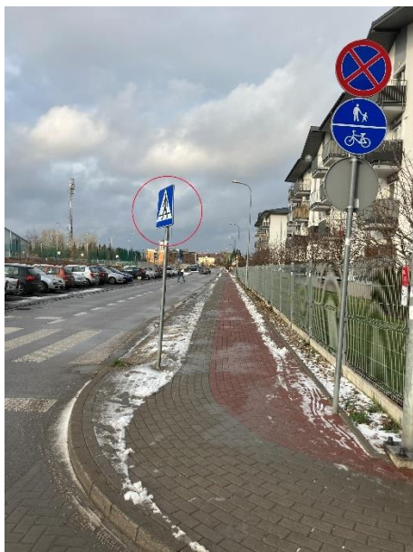
Zdjęcie 41: Przekręcona tarcza znaku D-6 „przejście dla pieszych”. Źródło: własne.
