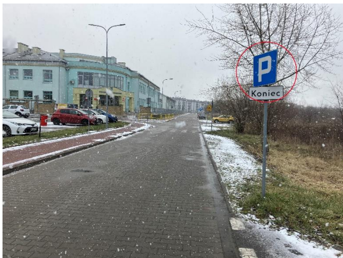
Zdjęcie 37: Przekręcona tarcza znaku D-19 „parking”. Źródło: własne.
