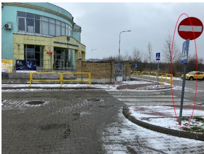
Zdjęcie 22: Krzywy słupek znaku B-2 „zakaz wjazdu”. Źródło: własne.
