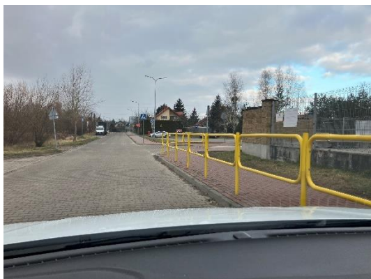
Zdjęcie 71: Widok na zjazd na parking szkolny – ograniczona widoczność pieszego przez murek ogrodzeniowy. Źródło: własne.
