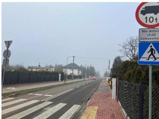
Zdjęcie 16: Widok od strony ul. Kościelnej – brak ograniczenia. Źródło: własne.
