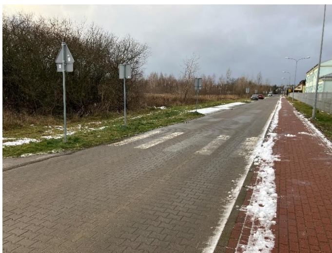
Zdjęcie 31: Brak znaku D-6 „przejście dla pieszych” z jednej strony przejścia. Źródło: własne.
