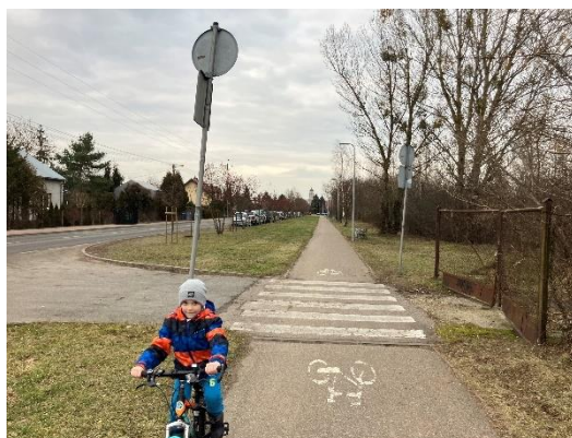
Zdjęcie 52: Przekręcone znaki C13/16 oraz D-6. Źródło: własne.
