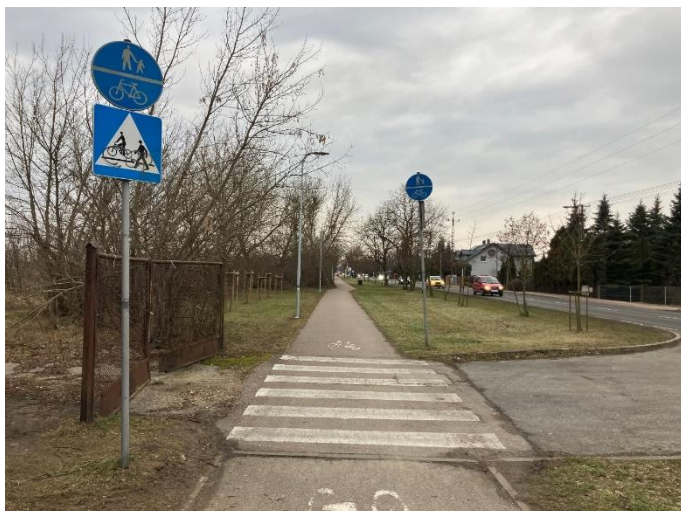
Zdjęcie 64: Niespójność oznakowania poziomego i pionowego. Źródło: własne.
