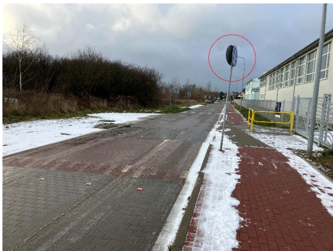
Zdjęcie 35: Przekręcona tarcza znaku C-13/16 i C-13a/16a. Źródło: własne.
