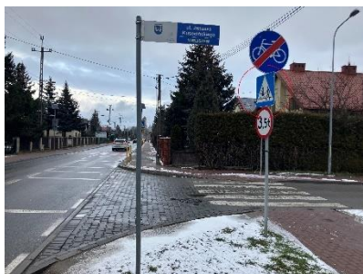
Zdjęcie 28, 29, 30: Nieprawidłowe zastosowanie znaku D-6b przy braku wyznaczonego przejazdu dla rowerów. Na zdjęciu 30 widoczny ruch rowerowy przez przejście dla pieszych, co wskazuje na potrzebę dostosowania infrastruktury. Źródło: własne.
