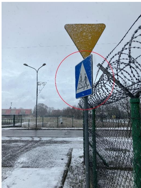
Zdjęcie 39: Przekręcona tarcza znaku D-6 „przejście dla pieszych”. Źródło: własne.
