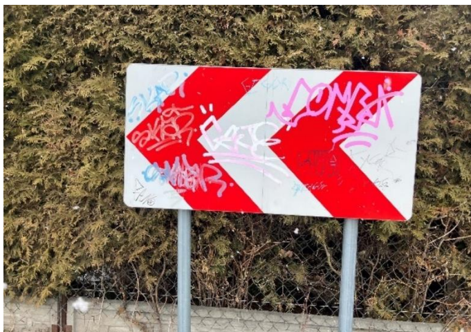
Zdjęcie 23: Brudna tablica prowadząca U-3d. Źródło: własne.
