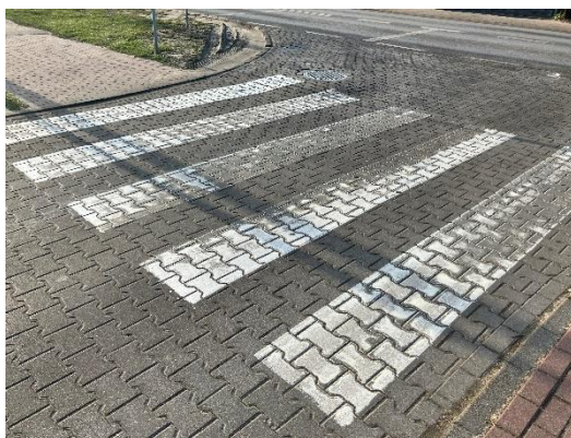
Zdjęcie 55: Przejście dla pieszych przez ul. J. Kusocińskiego przy ul. Kościelnej. Źródło: własne.
