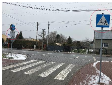
Zdjęcie 28, 29, 30: Nieprawidłowe zastosowanie znaku D-6b przy braku wyznaczonego przejazdu dla rowerów. Na zdjęciu 30 widoczny ruch rowerowy przez przejście dla pieszych, co wskazuje na potrzebę dostosowania infrastruktury. Źródło: własne.
