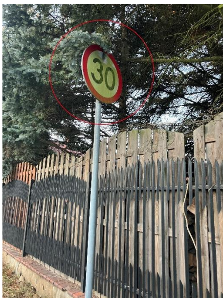
Zdjęcie 45: Przysłonięty i zabrudzony znak B-33 na ul. Podgórnej. Źródło: własne.
