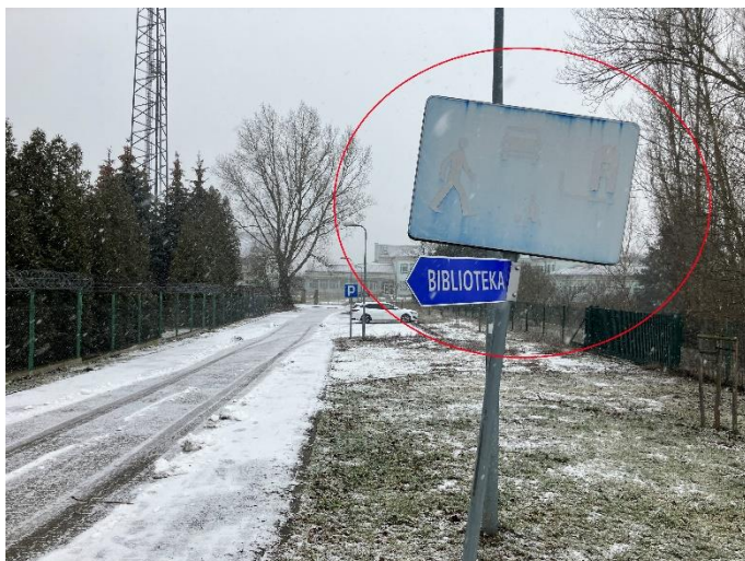
Zdjęcie 40: Wypłowiły znak D-40 „strefa zamieszkania” przy wjeździe na drogę do parkingu szkolnego od strony al. Solidarności. Źródło: własne.
