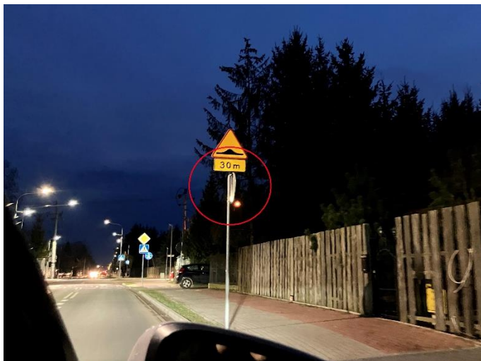
Zdjęcie 46: Przekręcone tarcze znaków B-33 „ograniczenie prędkości”. Źródło: własne.
