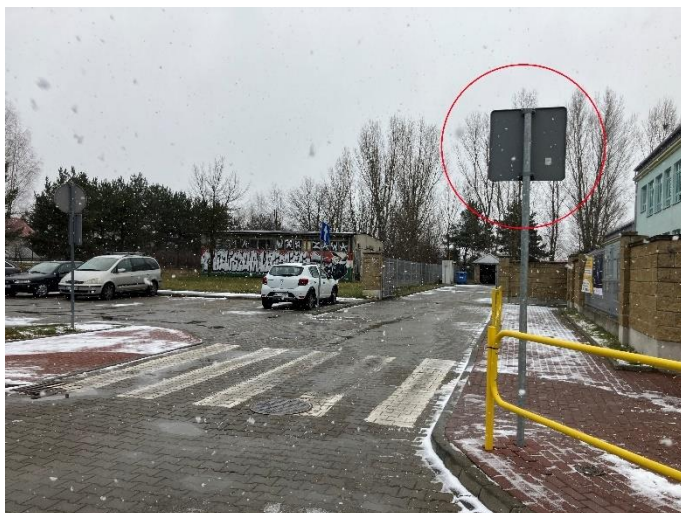
Zdjęcie 19: Przekręcona tarcza znaku D-6 „przejście dla pieszych”. Źródło: własne.
