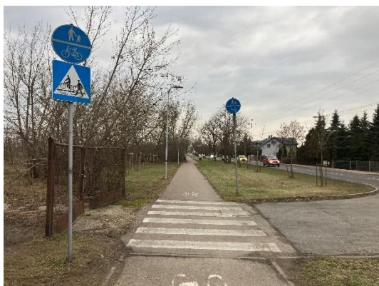
Zdjęcie 51: Przekręcone znaki C13/16 oraz D-6. Źródło: własne.
