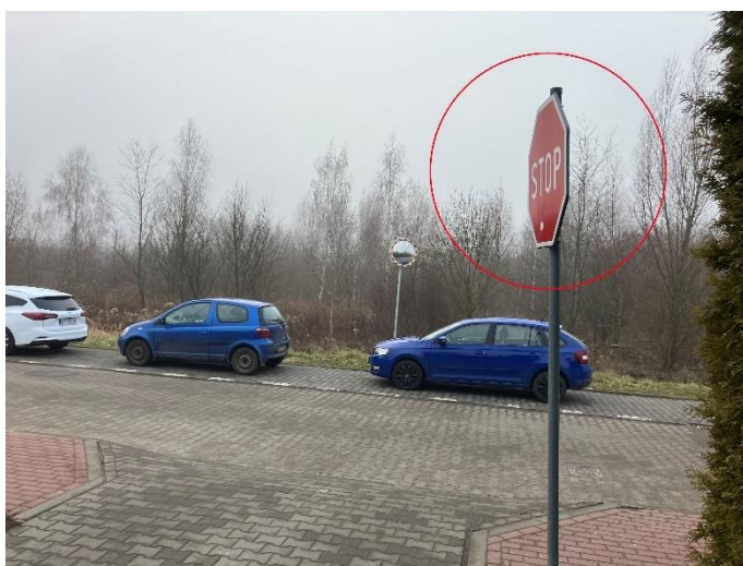
Zdjęcie 20: Przekręcona tarcza znaku B-20 „stop”. Źródło: własne.
